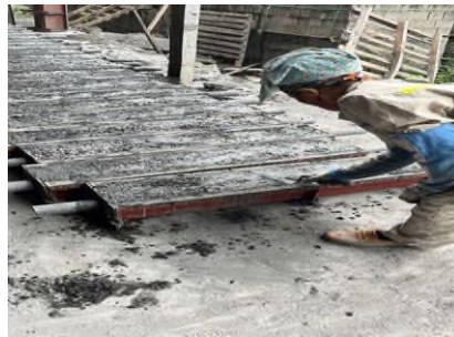
Hoàn thiện mặt
