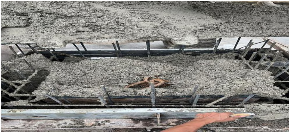
Hình ảnh đổ bê tông
